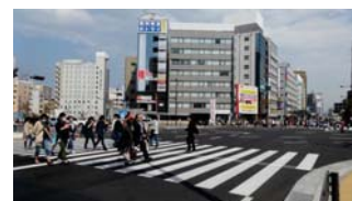
駅前国道10号線 横断歩道化
