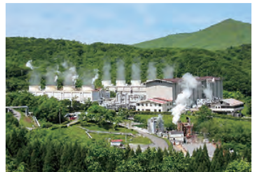
九電みらいエナジー(株)八丁原発電所
